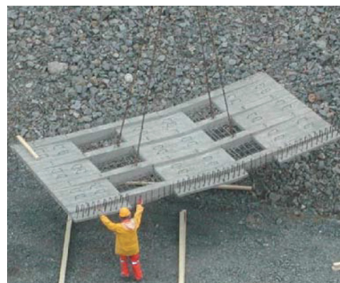
Brons ÖVERBYGGNAD BESTÅR AV TVÅ STYCKEN STÅLBALKAR MED EN SAMVERKANDE BROBANEPLATTA AV BETONG MED ETT FÖR SVERIGE UNIKT SEMIPREFAB-SYSTEM.
